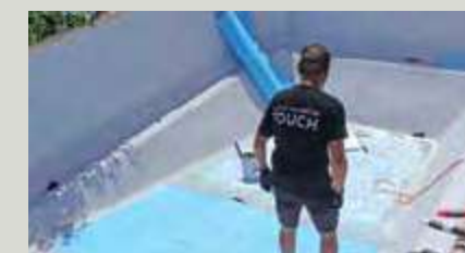
6. Boden stumpf oder überlappend verlegen.
