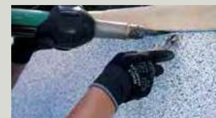
5. Wände mit RENOLIT ALKORPLAN TOUCH auskleiden.
