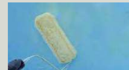
3. RENOLIT ALKORGLUE Kontaktkleber vollflächig auftragen.
